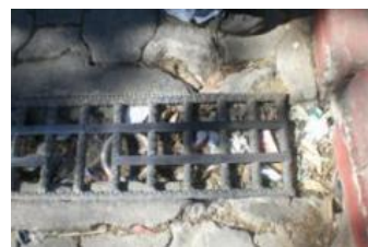
Tragantes: Unidades utilizadas para captar el agua de lluvia
