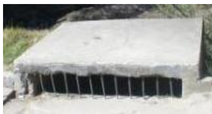
Tragantes: Unidades utilizadas para captar el agua de lluvia
