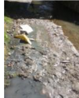
Fosa séptica que no funciona, se escapan las aguas residuales, que provienen del Centro de Salud.
