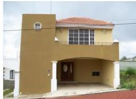
Viviendas del centro histórico – viviendas con construcción de block y losa
