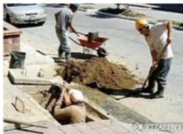
Limpieza de drenaje, trabajo municipal
